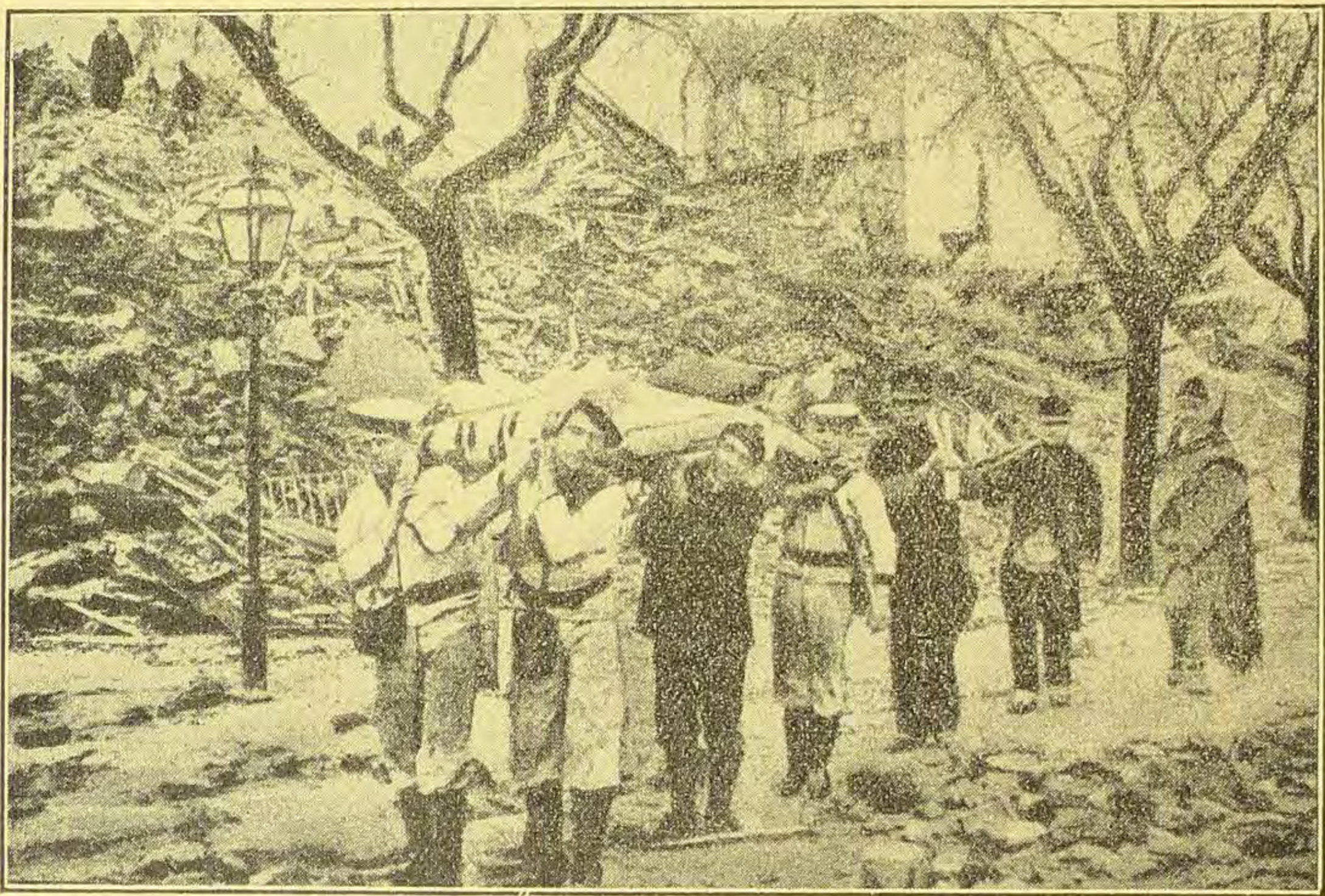
Potres u Italiji. Iznašanje mrtvih i ranjenih ispod ruševina.
