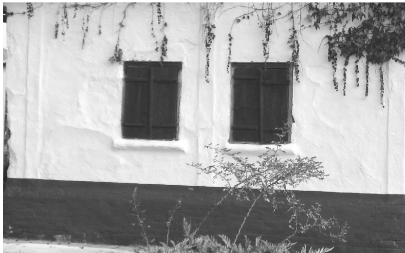
Fasada s ofarbanom coklom i drvenim kapcima na prozorima
