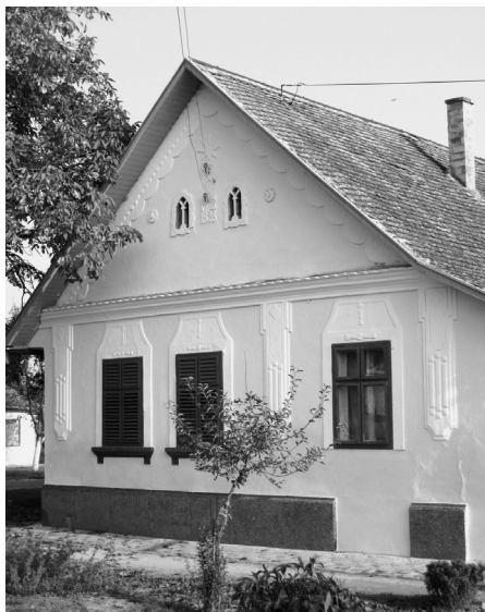
Fasada sa coklom od mramornih ploča
