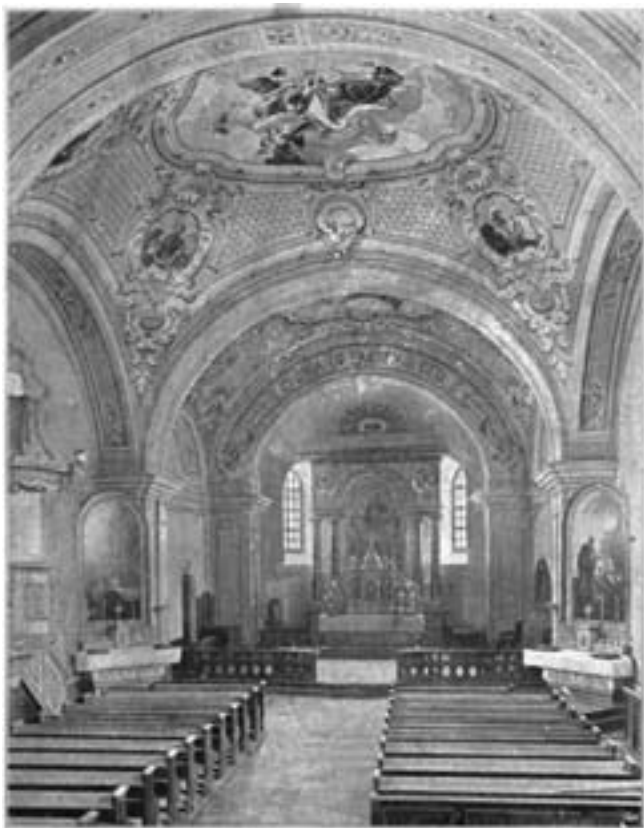
Az 1898-ban renovált plébária-templom Kulán, Bács m.
