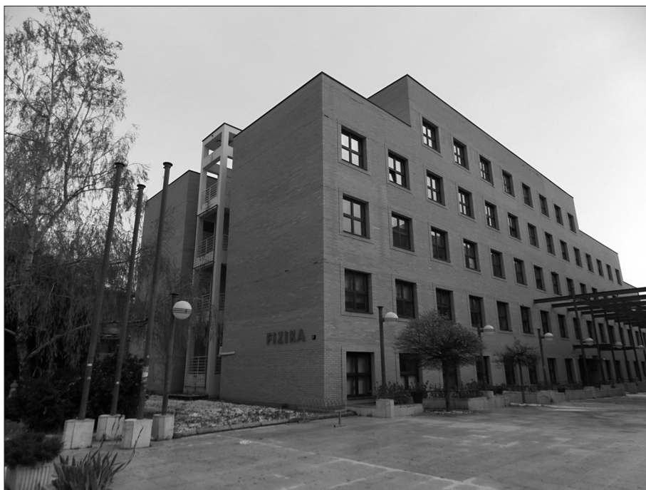
Slika 3. Zgrada Fizike, Bijenička 32
